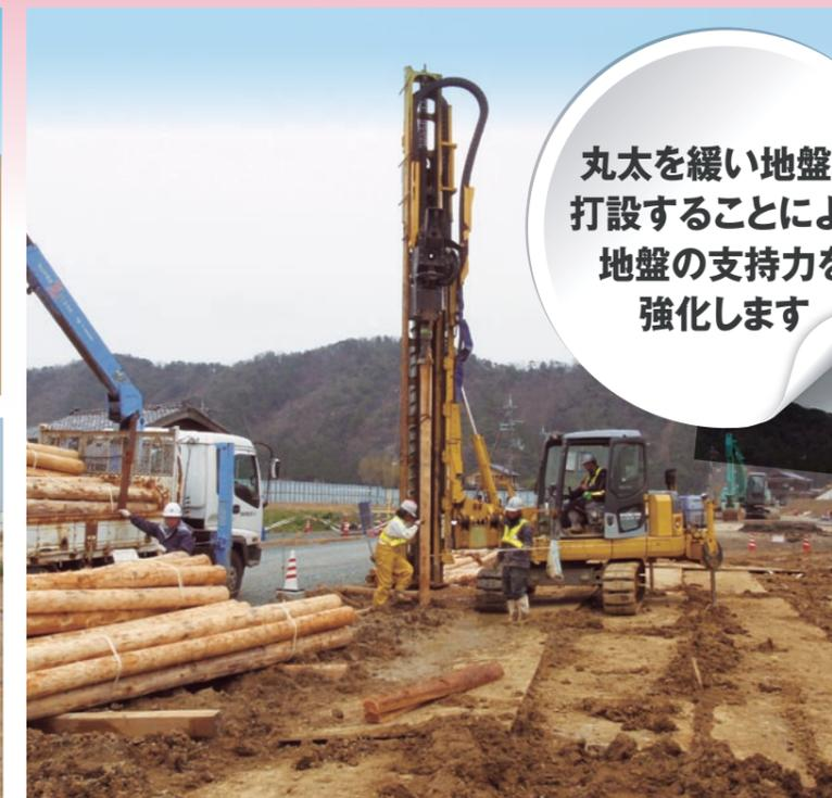
丸太を緩い地盤に打設することにより地盤の支持力を強化します
